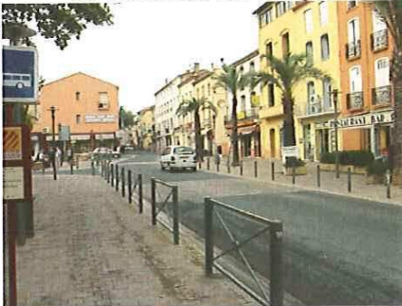
Entrée Ouest par la RD 916 à sécuriser.
