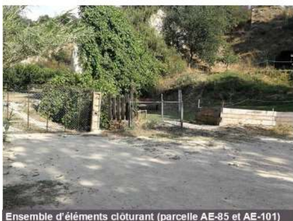
Ensemble d'éléments clôturant (parcelle AE-85 et AE-101)
