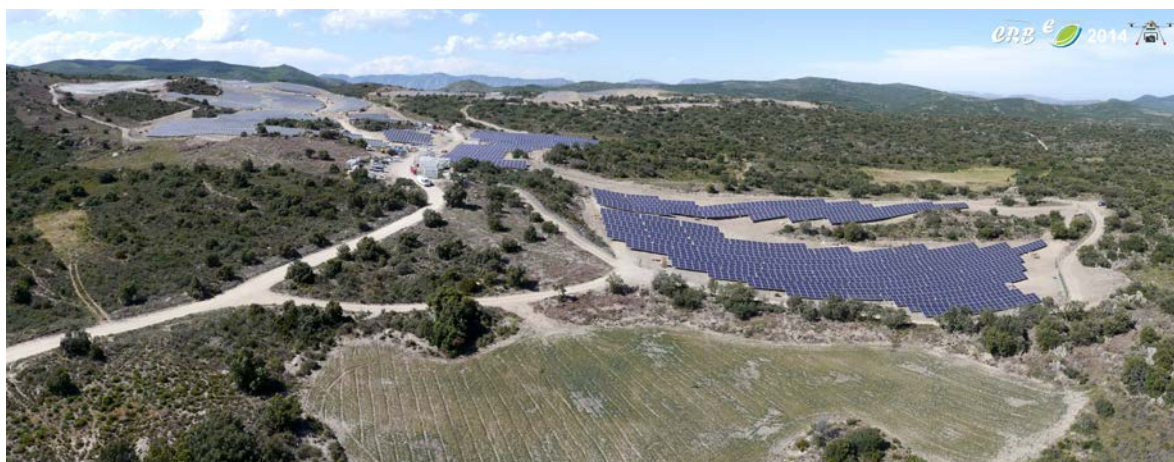
Ferme photovoltaïque d'Ile sur Tet
