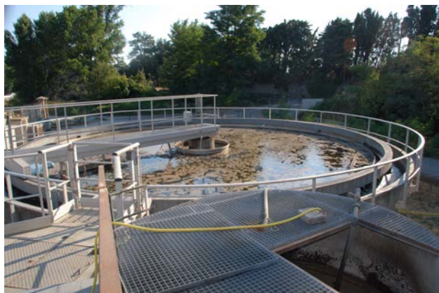
Ancienne station d'épuration
