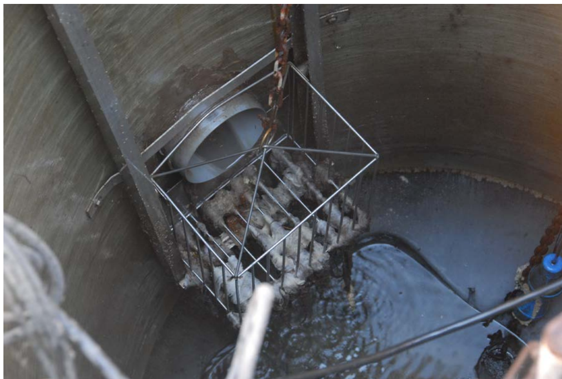
Problème des lingettes et autres détritrus jetés dans les toilettes.
