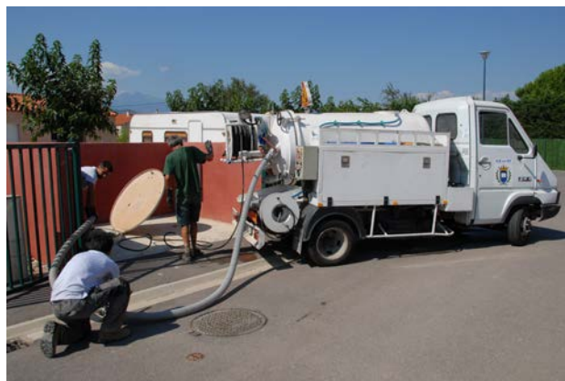
Poste de relevage
