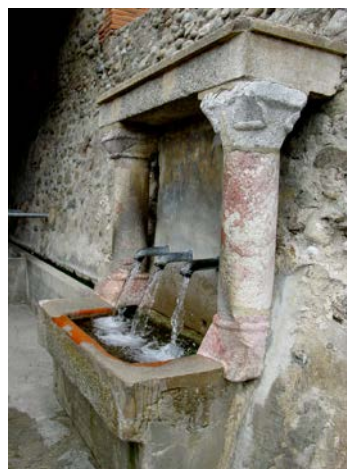
Fontaine d'en Ribalte
