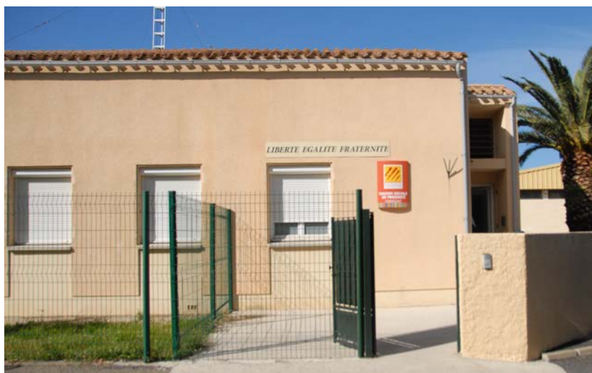
Maison sociale de proximité, chemin des Castellounes
