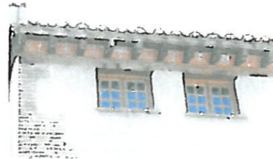
Sous-toit place St Jacques
